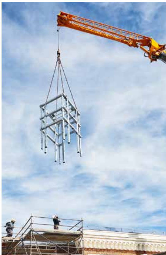
Das Lifgerüst kommt.
