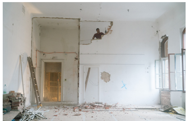
Proberaum Sanierung (c) Franziska Liehl
